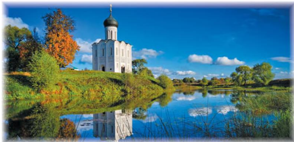
Боголюбово. Церковь Покрова на Нерли
